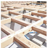
剛床工法 床剛性3.7倍 大引工法
