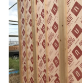
壁断熱 冷凍倉庫用断熱材を採用
