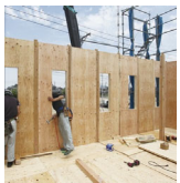
耐震壁パネル 壁倍率4.0倍
